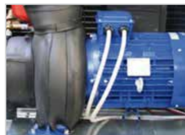
Bomba de agua de caudal variable.
