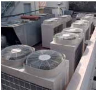
Hotel Dimar, Valencia Sistema de caudal variable.
