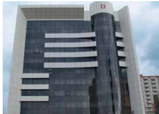
Capital Bank, Baku (Azerbaijan) Sistema de caudal variable. Climatización.
